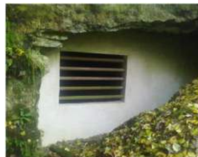
Aménagement avec parpaings et grille – DocOb « Sites chiroptères du Vexin français », Parc Naturel Régional du Vexin Français
