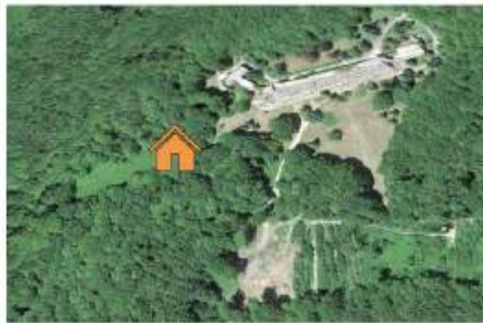
Localisation du gîte de substitution – Google Earth
