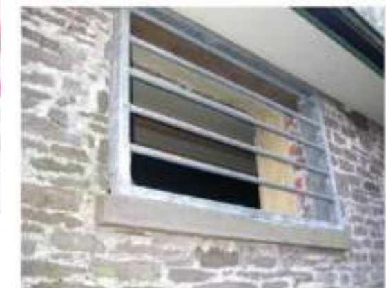
Ouverture aménagée dans un bâtiment occupé par des petits Rhinolophes – P. Verté
