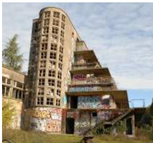
Le bâtiment des Tamaris est inscrit, de même que celui des Peupliers et que la station d'épuration de l'ancien sanatorium.
