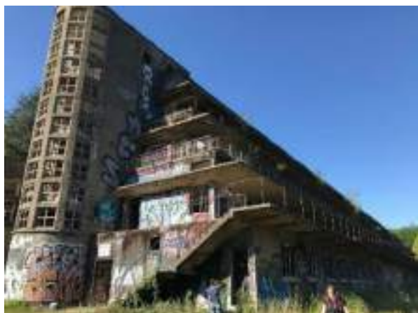
Angle Sud-Ouest du bâtiment B- Ecosphère
