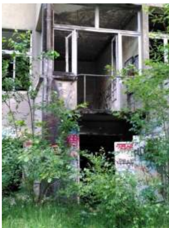
Façade Nord du bâtiment B (Porte 61) - Ecosphère
