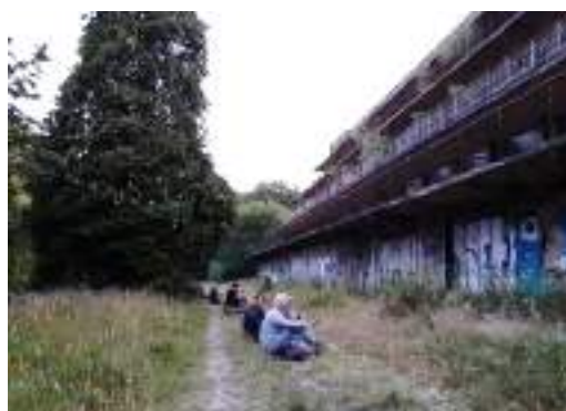
Observateurs en place devant les ouvertures le long du bâtiment B en façade Sud - Ecosphère
