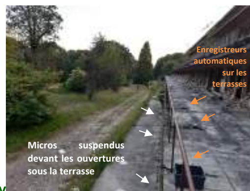
Mise en place des enregistreurs automatiques complétant les points d'écoute et d'observation manuelle pour détecter des individus sortant par les ouvertures en-dessous sous les terrasses (1 micro pour 2 ouvertures) en façade Sud et en façade Nord du bâtiment B - Ecosphère
