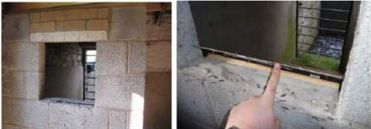
Modèle de dispositif anti-prédateurs avec appui de fenêtre basculant – Nyssen & C. Borel
