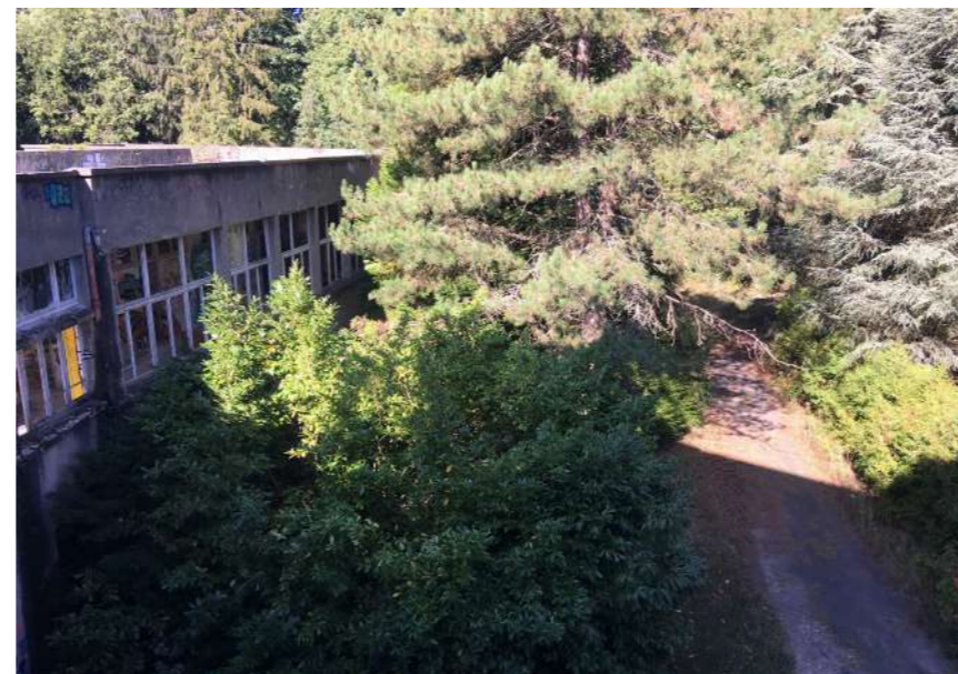
Aile Ouest du pavillon
