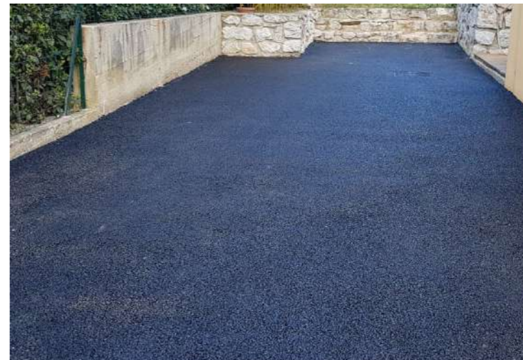
PLACES STATIONNEMENT PMR - Enrobé noir
