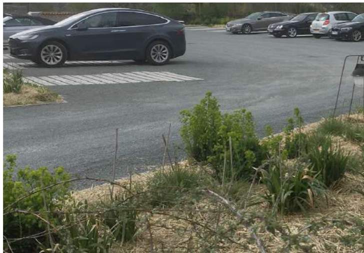
VOIERIE - Bicouche gravillonné
