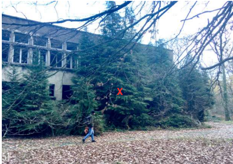
51 1 Haie de feuillus, moyens et grands sujets. Implantée en pied de façade, sur future zone de chantier et de plantations.
