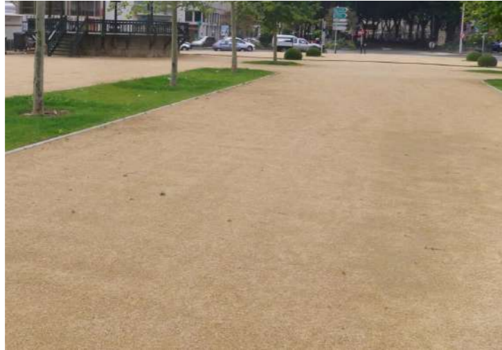
CHEMINEMENTS PIÉTONS - Sable stabilisé renforcé
