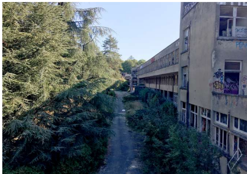
Voirie et façade Nord
