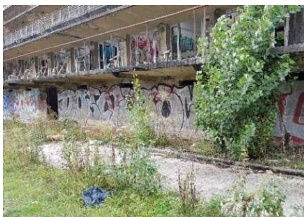
Façade Sud du bâtiment B (vue vers l'Ouest) - Ecosphère
