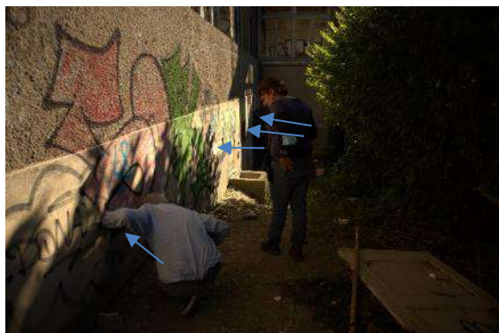
Façade Nord du bâtiment B (sopiraux 48 à 50 et Porte 6o) - Ecosphère
