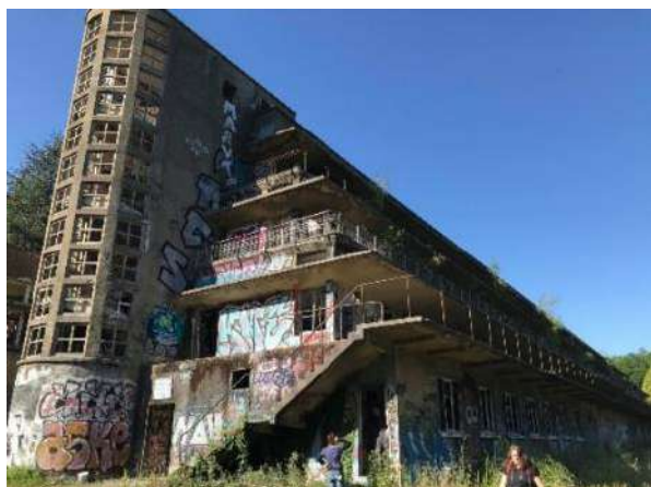
Angle Sud-Ouest du bâtiment B- Ecosphère
