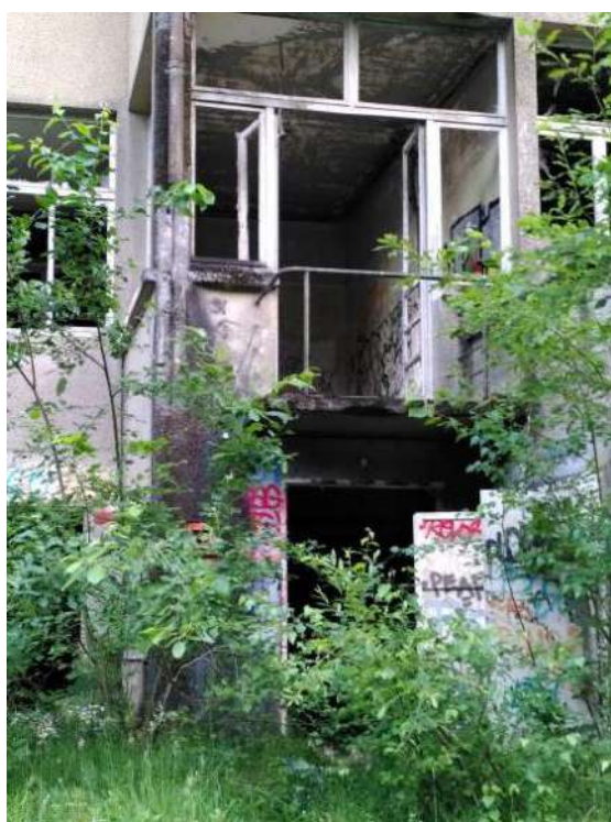
Façade Nord du bâtiment B (Porte 61) - Ecosphère
