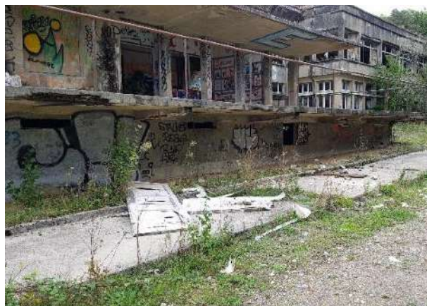
Extrémité Est de la façade Sud du bâtiment B (vue vers l'Est) - Ecosphère
