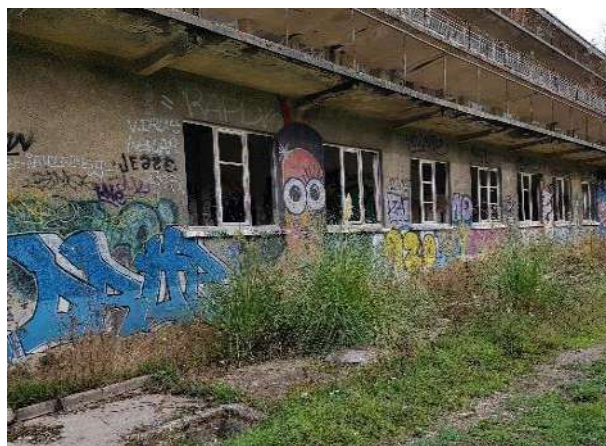
Façade Sud du bâtiment B (vue vers l'est) - Ecosphère
