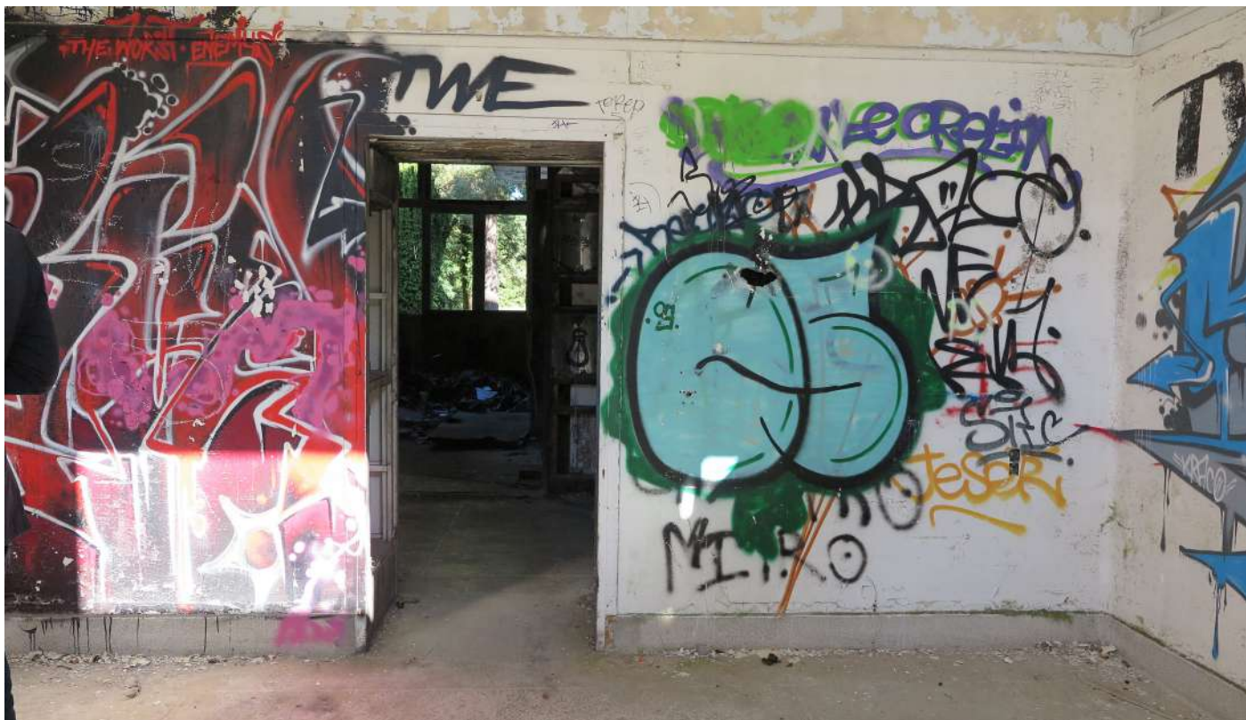
BÂTIMENT B - REZ-DE-CHAUSSÉE CHAMBRE
