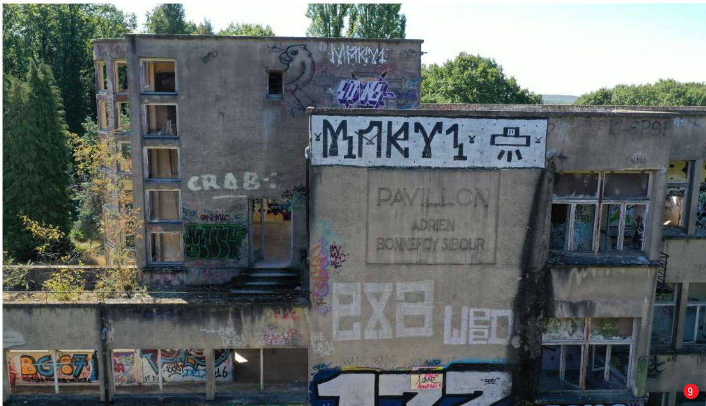
FRONTON DE L'ENTRÉE DU BÂTIMENT B ESCALIER EST DU BÂTIMENT B
