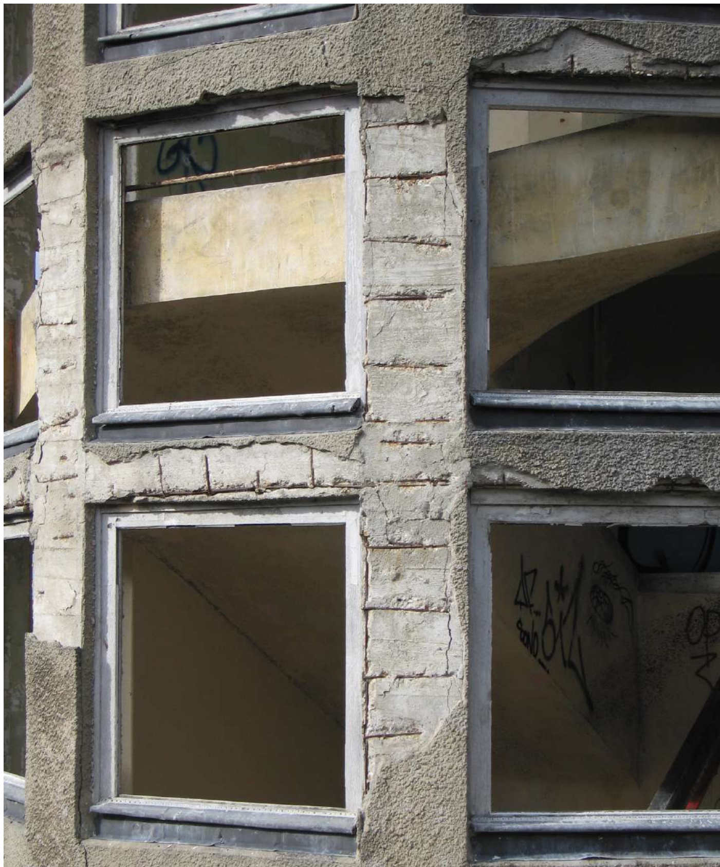
FAÇADE DE L'ESCALIER EST BÂTIMENT B
