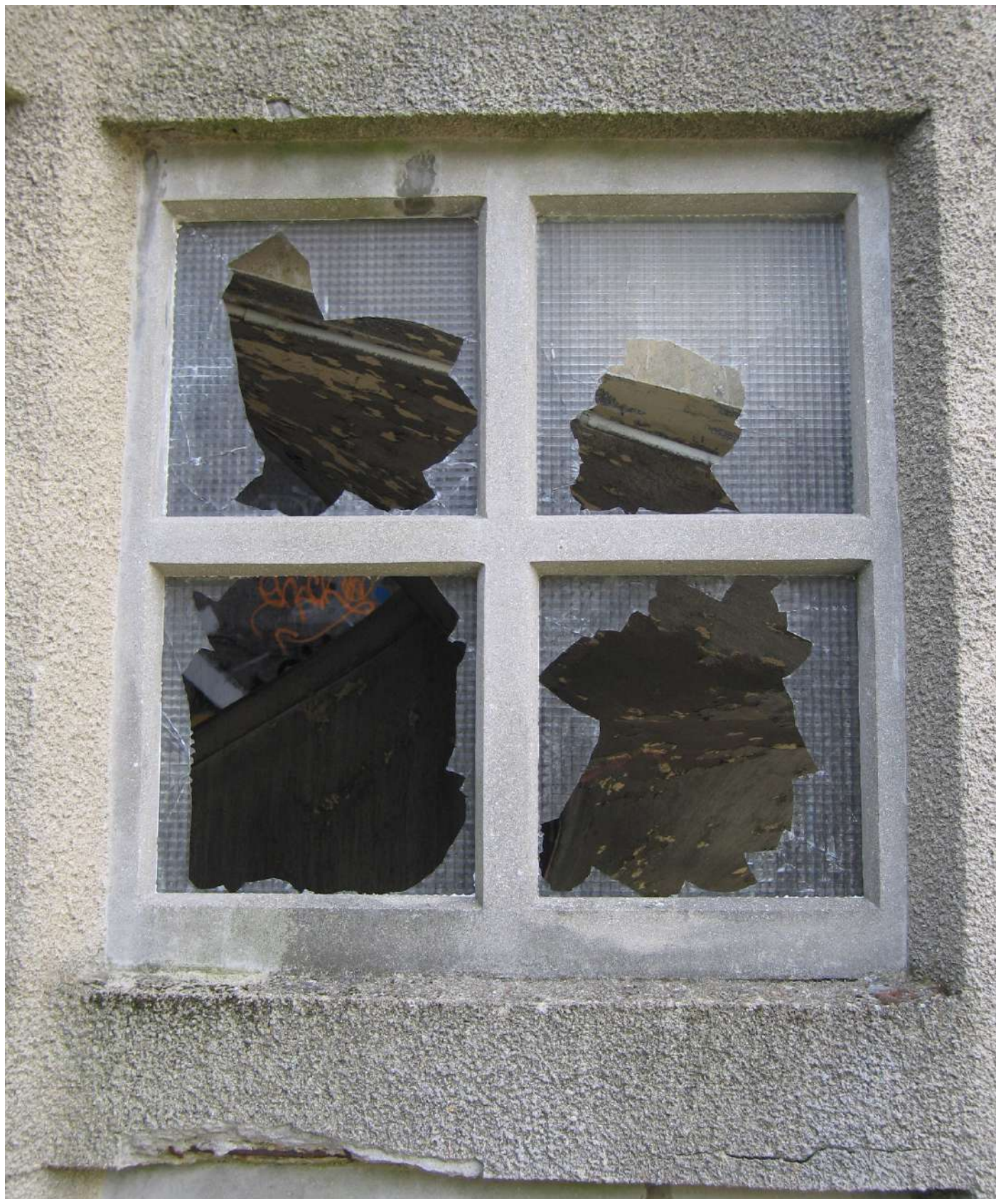
CROISÉE FIXE EN BÉTON ARMÉE BÂTIMENT B - ESCALIER OUEST
