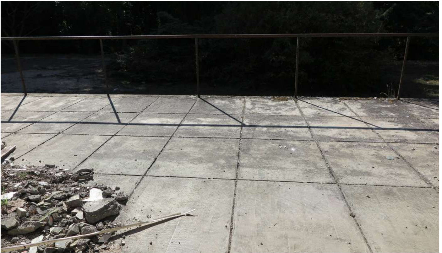
BÂTIMENT B - REZ-DE-CHAUSSÉE DALLES CIMENT SUR LIT DE SABLE
