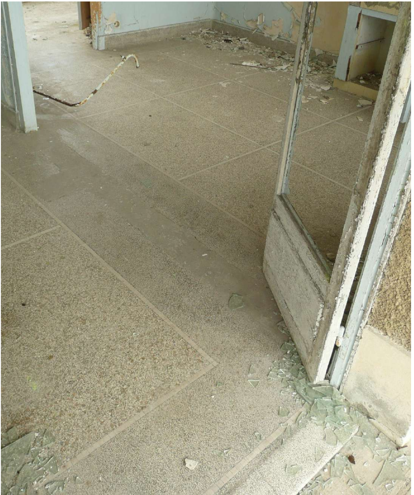
SOL GRANITO INTÉRIEUR DU BÂTIMENT B
