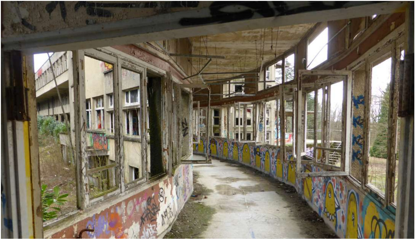
GALERIE OUEST - REZ-DE-CHAUSSÉE VUE VERS LE BÂTIMENT B
