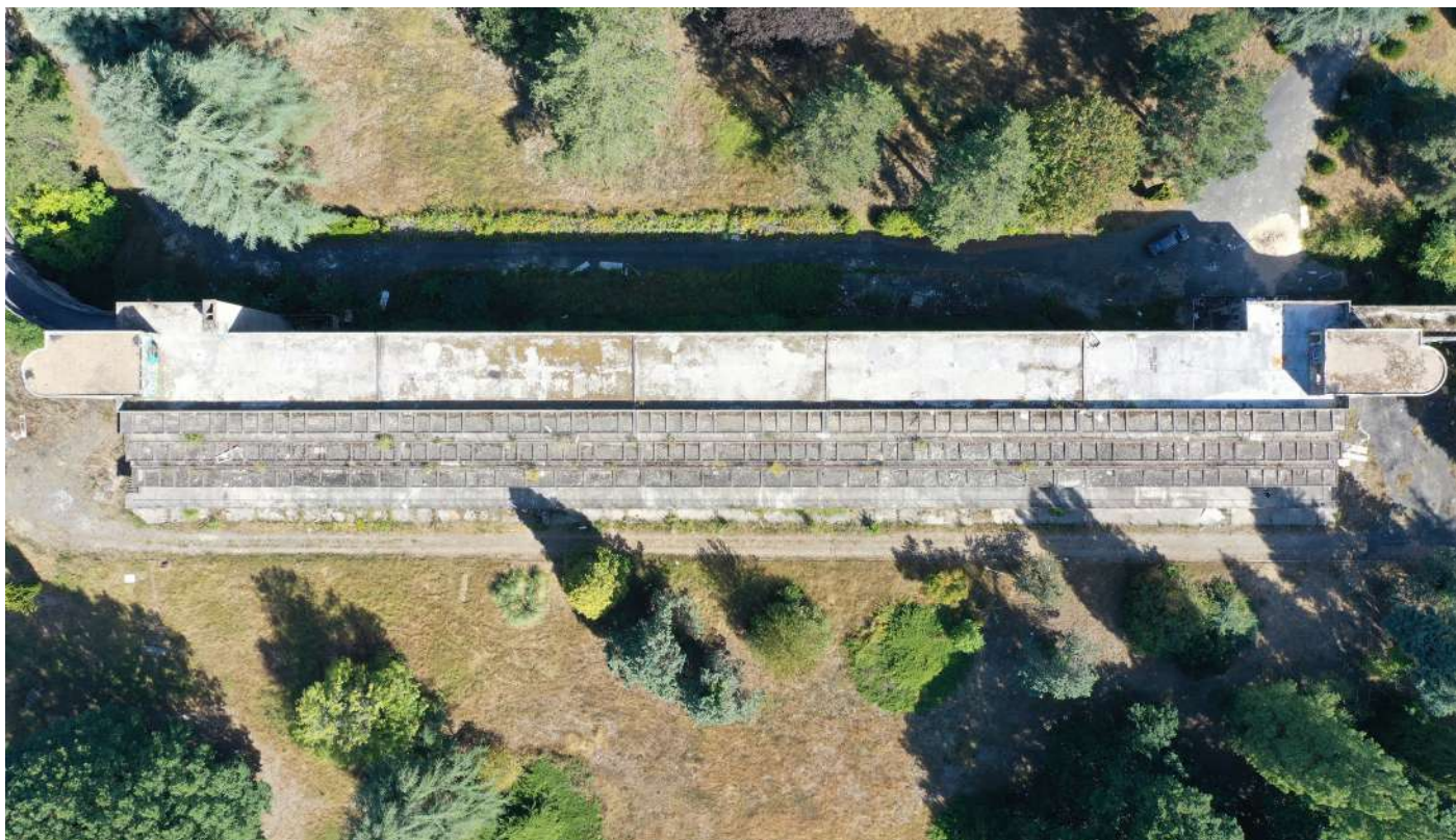
VUE DU CIEL DU BÂTIMENT B
