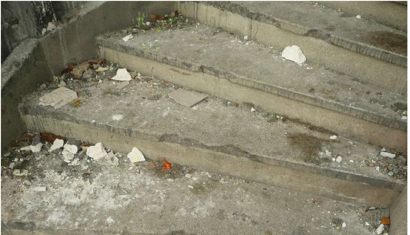
NEZ DE MARCHE ET CONTREMARCHE GRANITO - ESCALIER BÂTIMENT B
