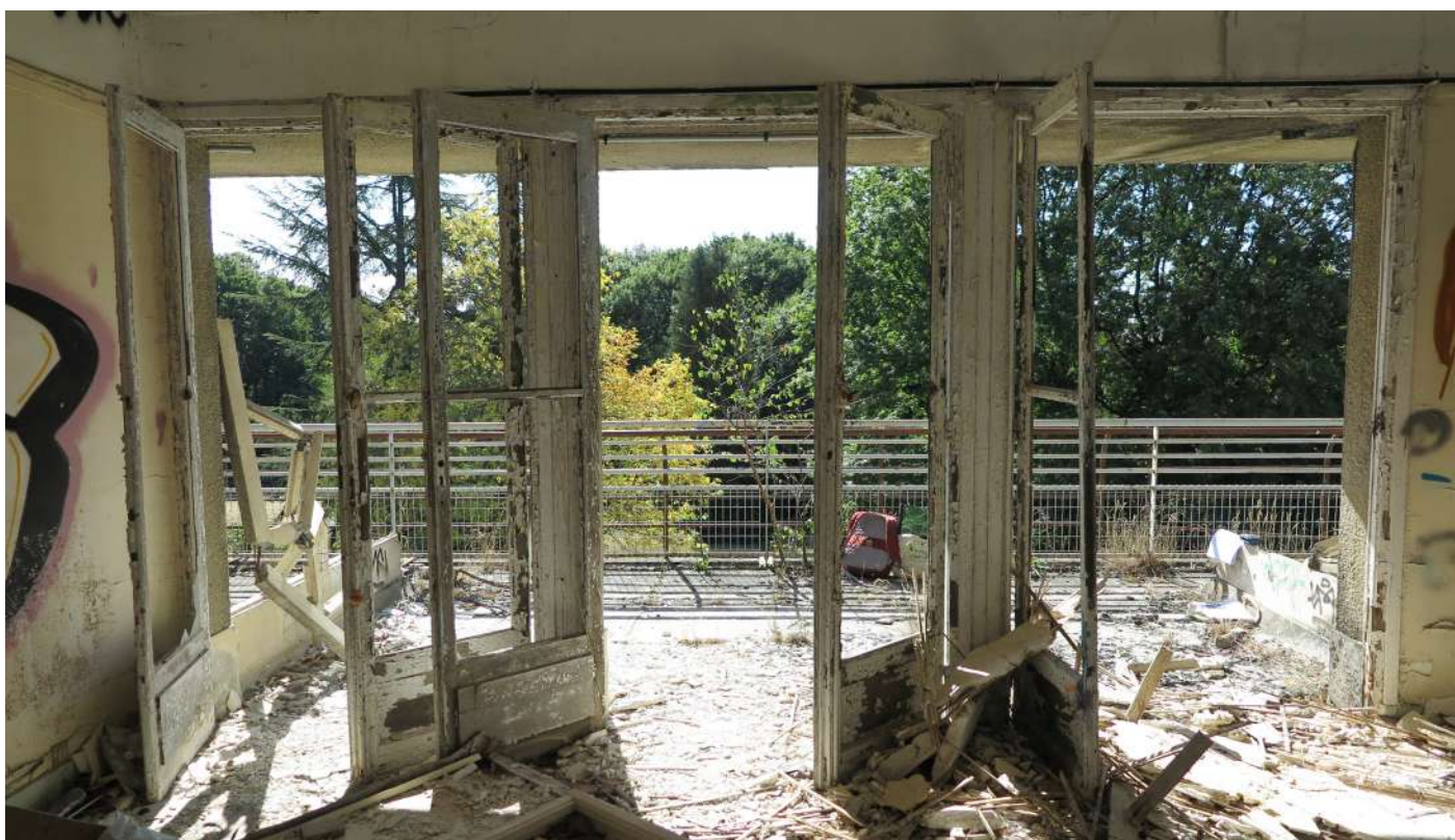
BÂTIMENT B - PREMIER ÉTAGE PORTES-FENÊTRES D'UNE CHAMBRE
