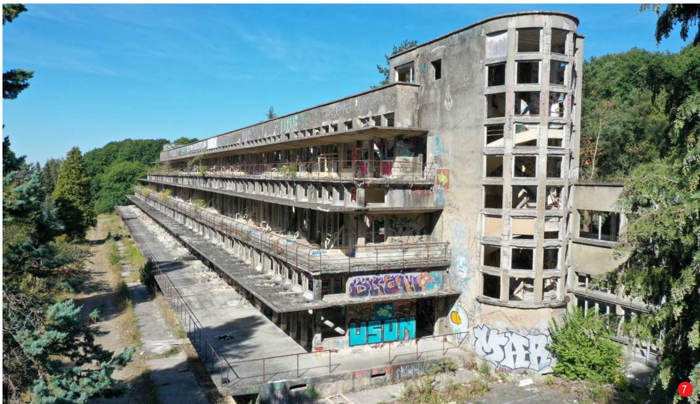
ANGLE SUD-EST DU BÂTIMENT B
