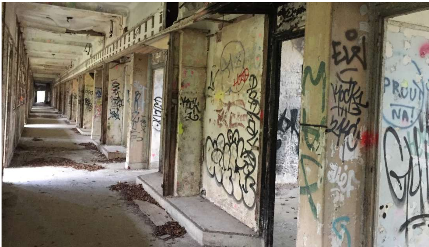
BÂTIMENT B - REZ-DE-CHAUSSÉE (C68) VUE VERS LE HALL D'ENTRÉE
