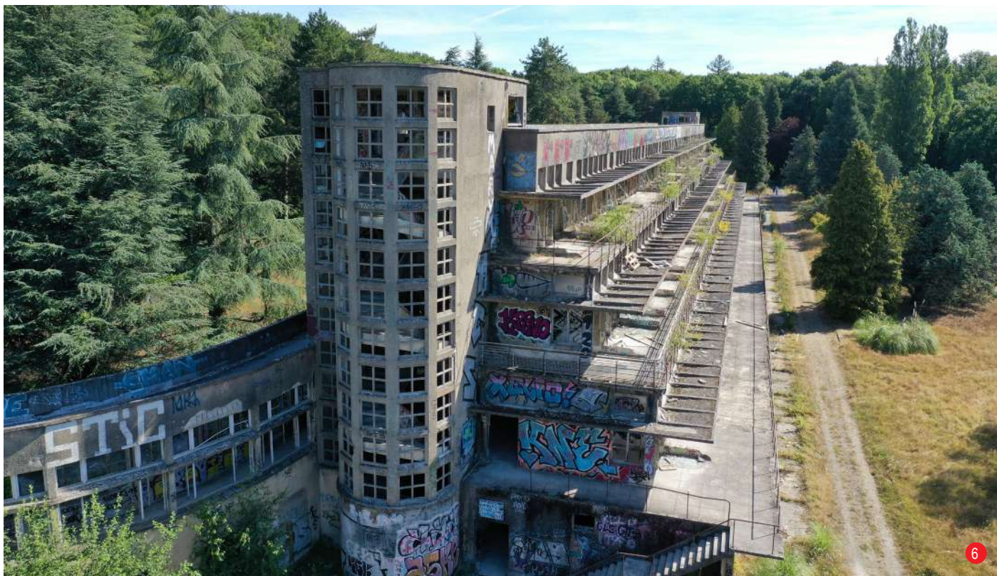
ESCALIER OUEST DU BÂTIMENT B
