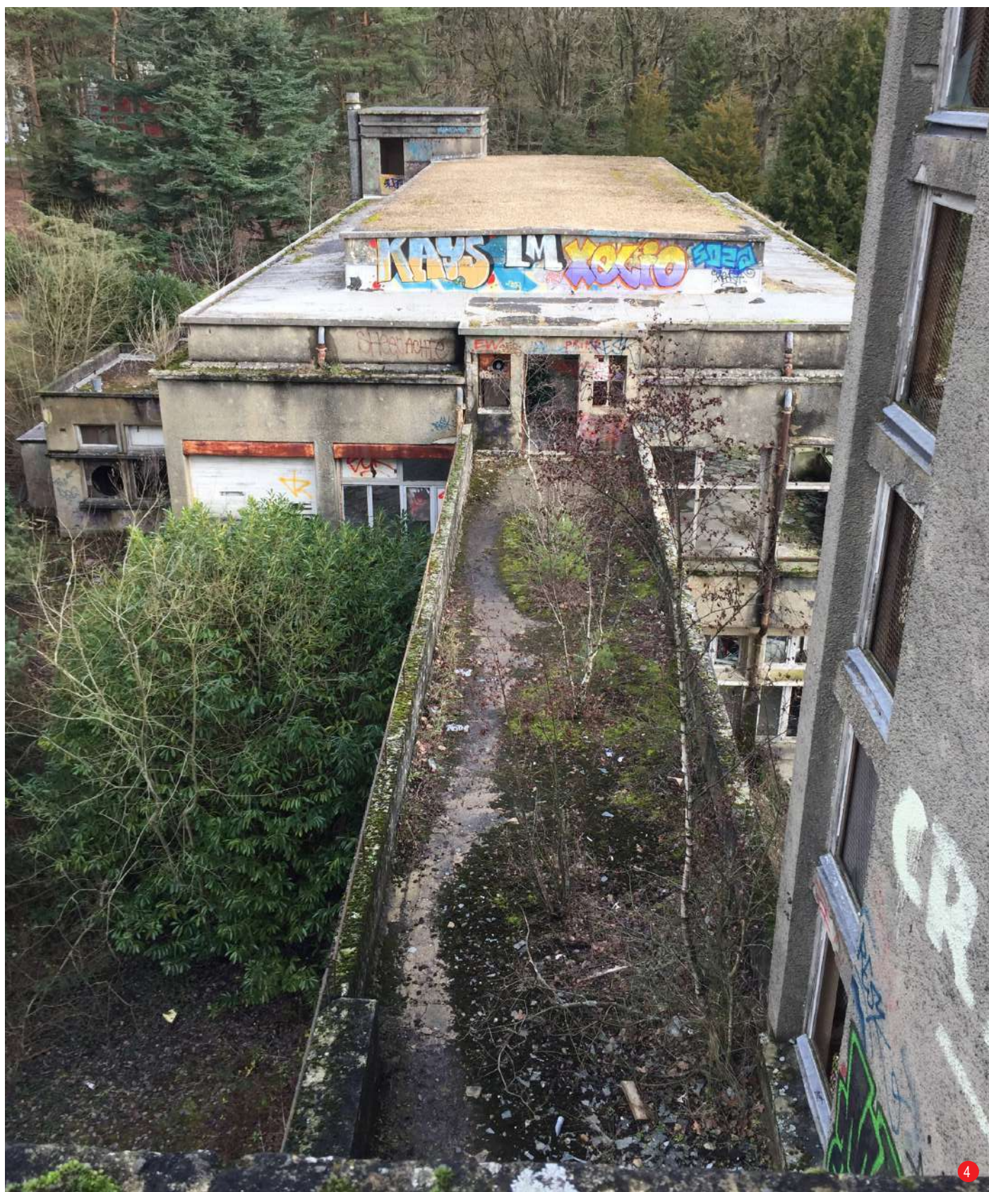
COUVERTURE DU BÂTIMENT A TOITURE TERRASSE DE LA GALERIE EST
