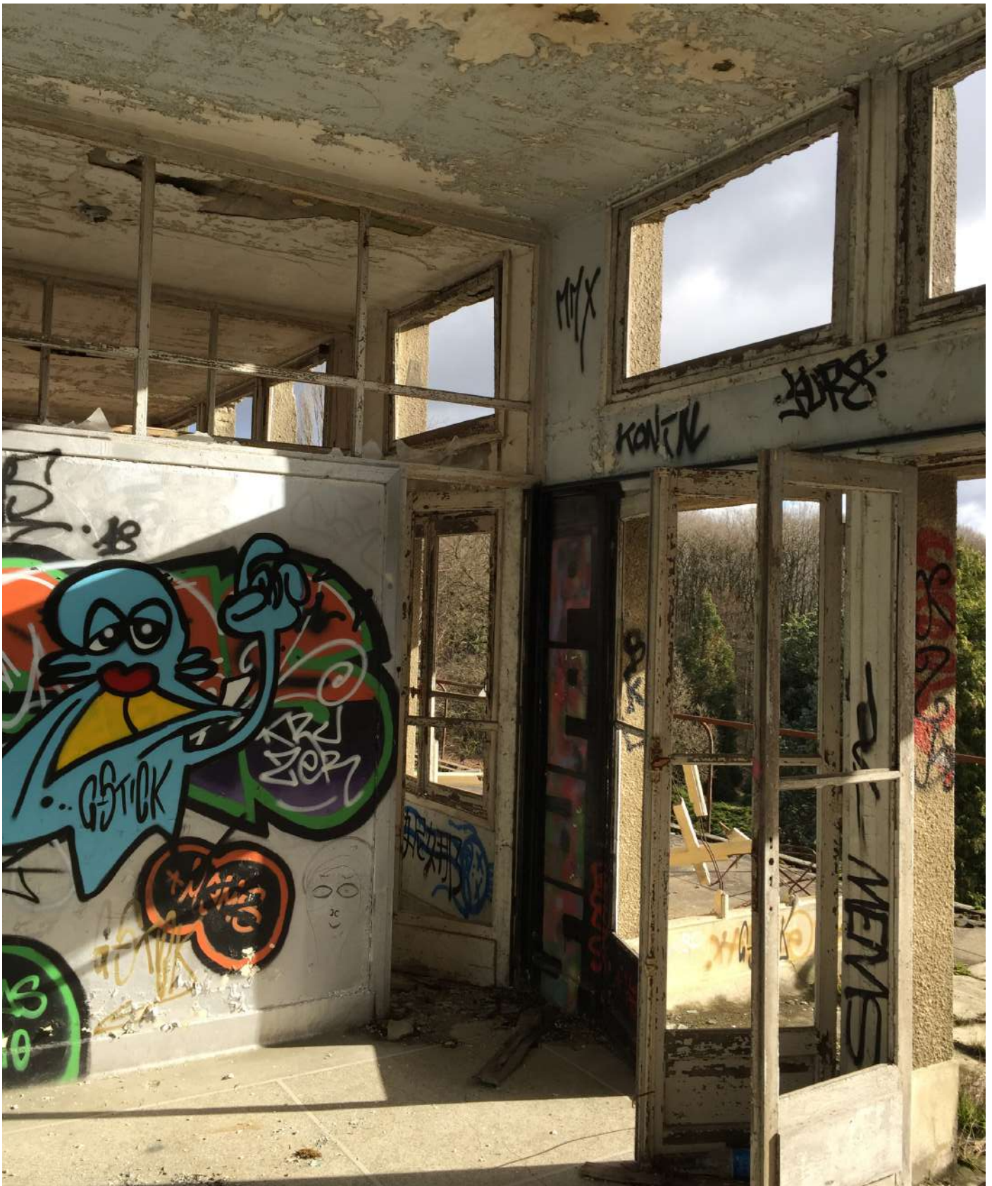
BÂTIMENT B - PREMIER ÉTAGE CHAMBRE ET SALLE D'EAU
