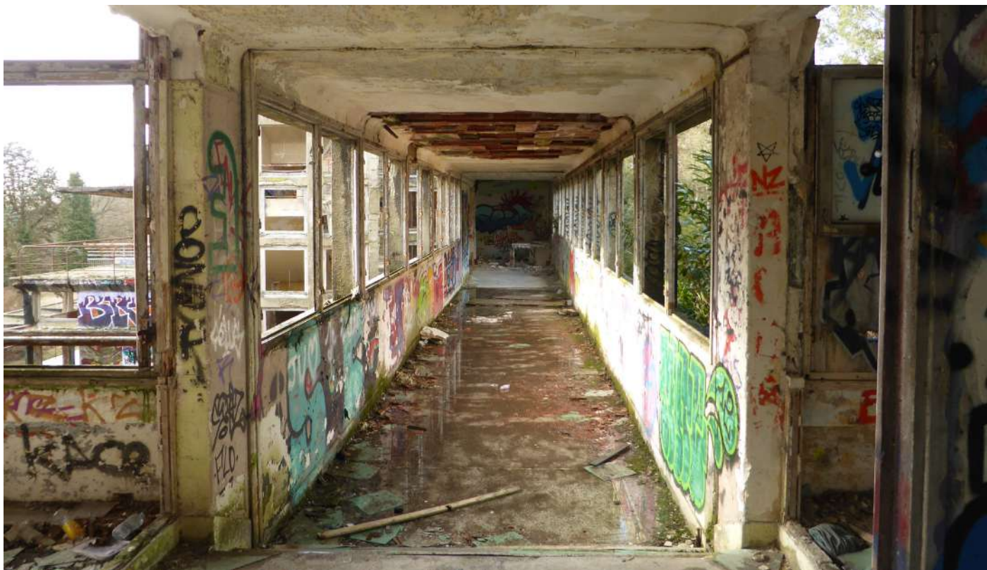
GALERIE EST - PREMIER ÉTAGE VUE VERS LE BÂTIMENT B
