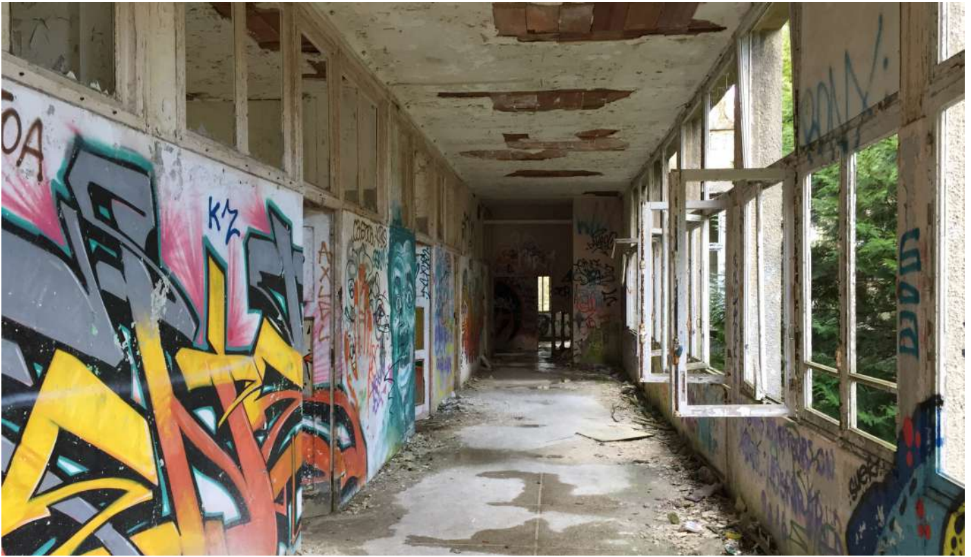
BÂTIMENT C - PREMIER ÉTAGE (C16) VUE VERS L'OUEST
