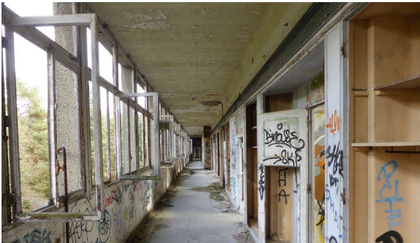
BÂTIMENT B - DEUXIÈME ÉTAGE (E20) VUE VERS L'ESCALIER EST
