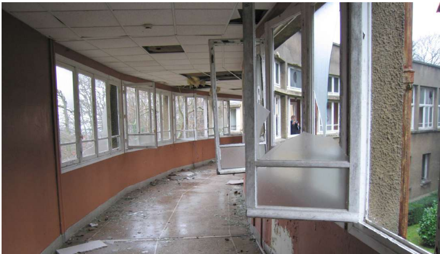
GALERIE OUEST - REZ-DE-CHAUSSÉE VUE VERS LE BÂTIMENT C
