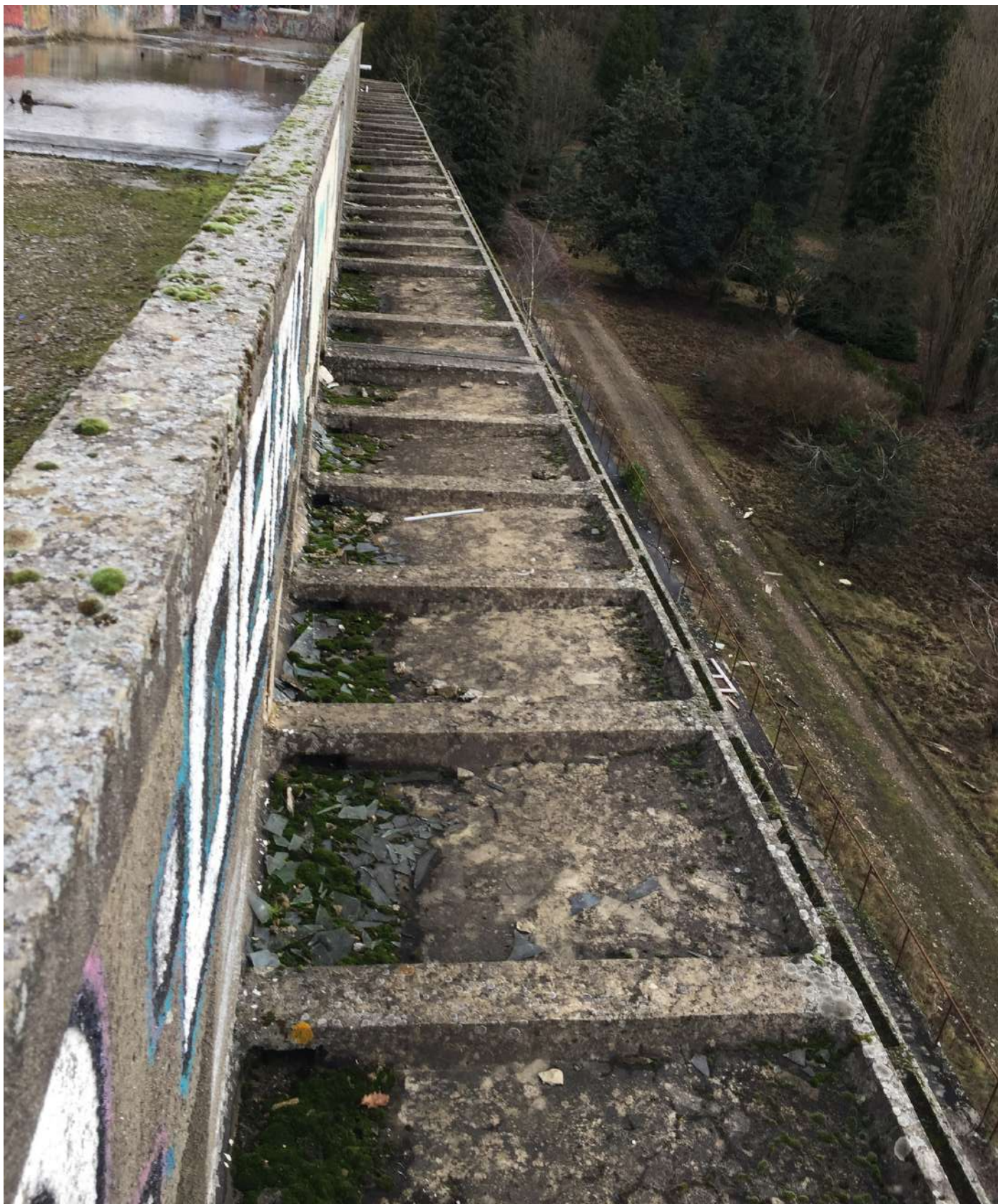
BÂTIMENT A - DEUXIÈME ÉTAGE AUVENT SUR TERRASSE
