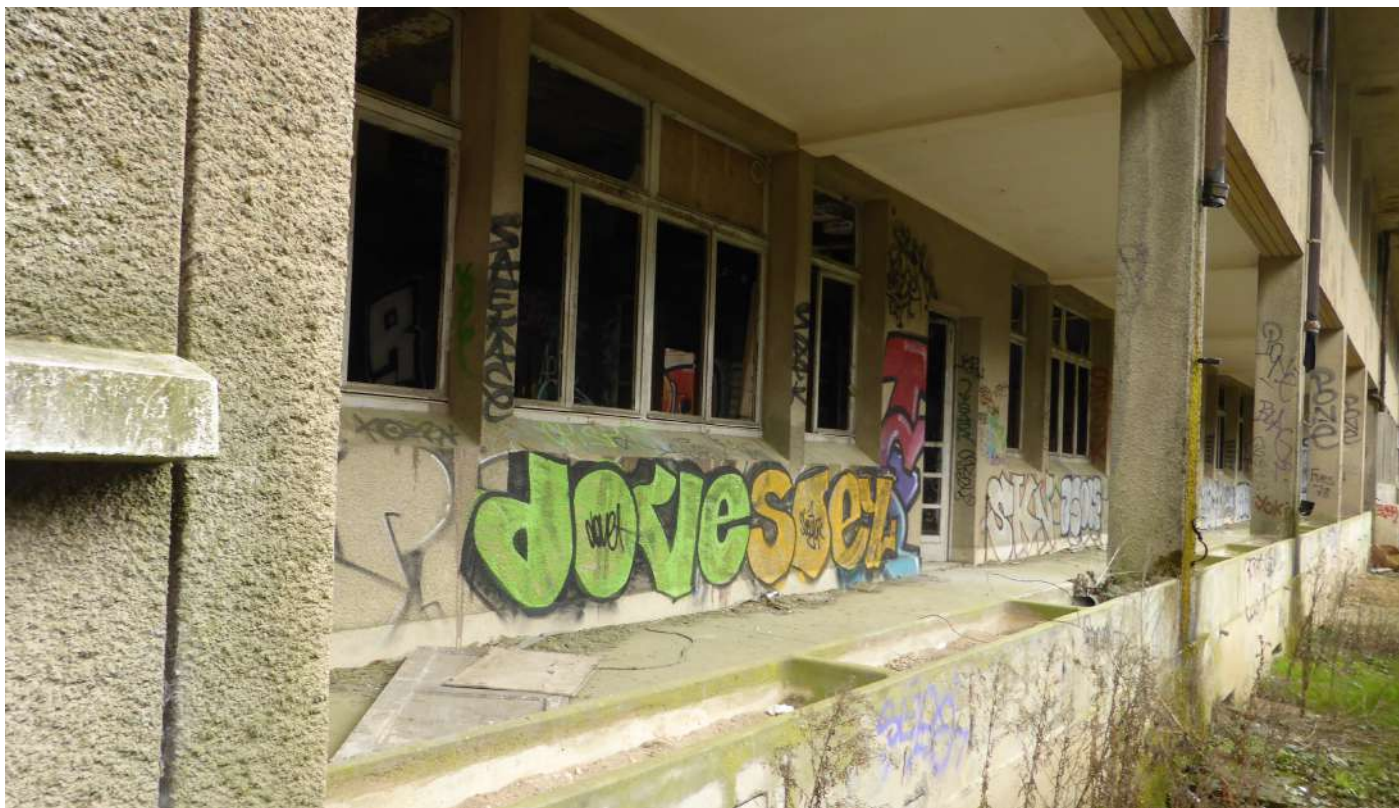
BÂTIMENT B - REZ-DE-CHAUSSÉE PRÉAU NORD
