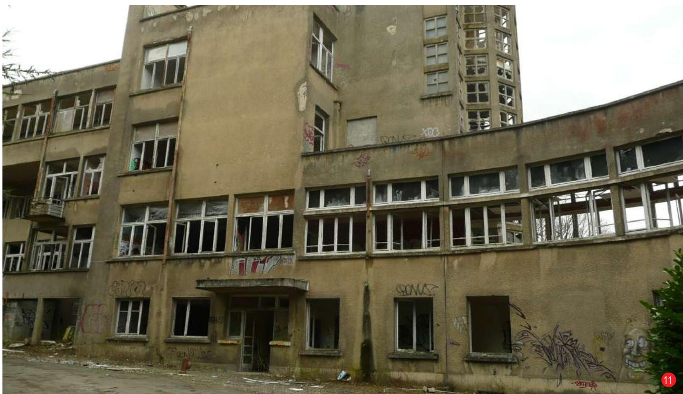
ENTRÉE REZ-DE-JARDIN DU BÂTIMENT B GALERIE OUEST
