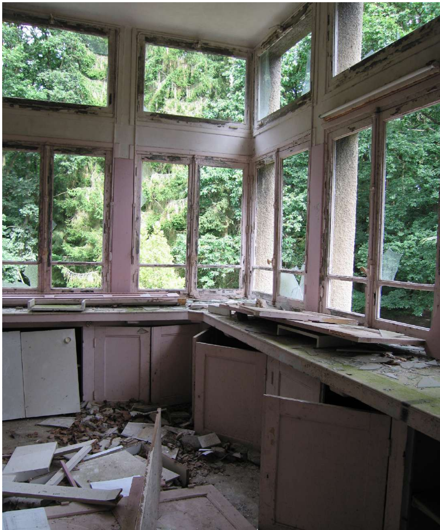
ANGLE NORD-OUEST REZ-DE-CHAUSSÉE PIÈCE (C5) - BÂTIMENT C
