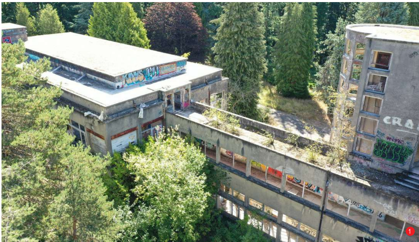
COUVERTURE DU BÂTIMENT A ET GALERIE EST
